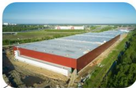
Склад «Армада Парк Север». Общая площадь: 50,0 тыс. кв. м
